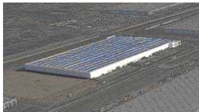
SCE社が屋根を借りて太陽光発電パネルを設置した工場(SCE社提供)
